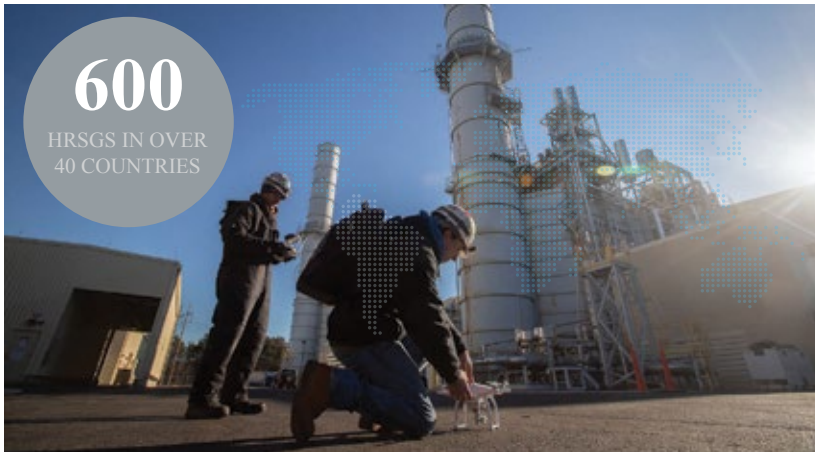
Preparing for a HRSG Drone Inspection
