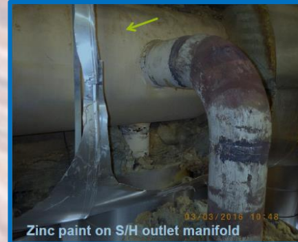
Effect of Zinc paint on P91 HRSG components
