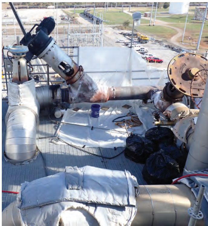
7. Damaged main steam isolation valve above HRSG
